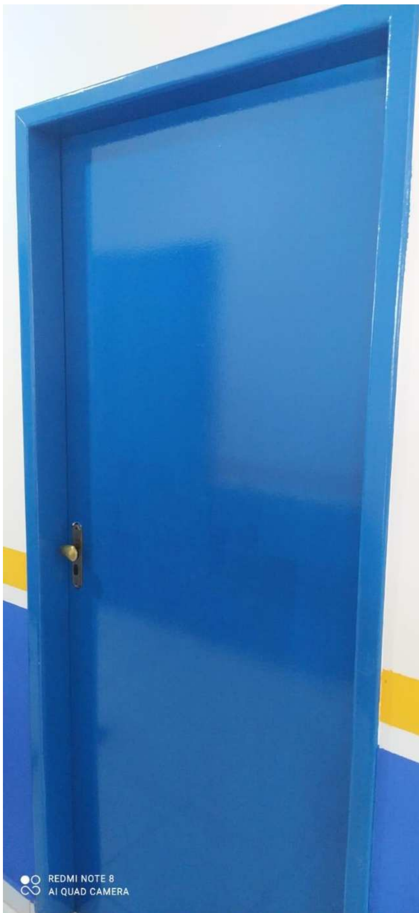
UBS - SAFIRA Rua 20, s/n - Residencial Safira - Paço do Lumiar/MA
